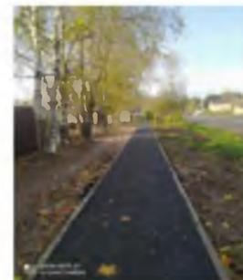
4. Текущий ремонт тротуара по Ленинградскому тракту в г. Вытегра. Выполнен ремонт тротуара из асфальтобетонных смесей, обустройство бордюрного камня.
