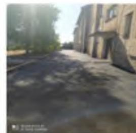
3. Текущий ремонт тротуара и парковки по улице Урицкого в г. Вытегра. Выполнен ремонт тротуара с использованием асфальтобетонных смесей, обустройство бордюрного камня, парковки.
